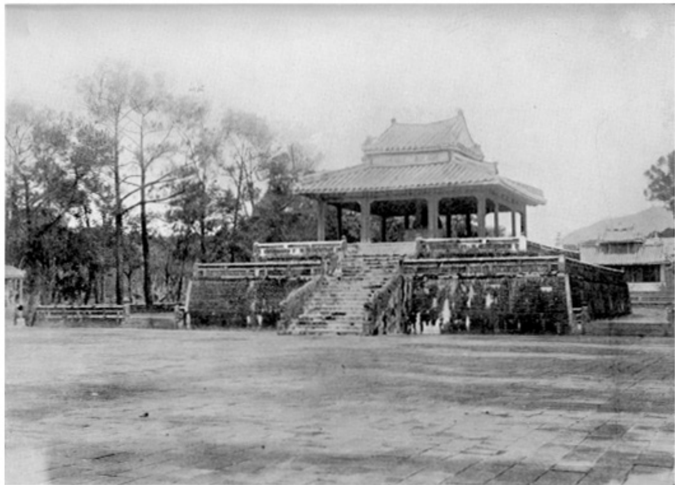
Planche LXXII. — Le pavillon de la Stèle, façade antérieure, en son état primitif, au Tombeau de Minh - Màng, (Photographie communiquée par M. Ch. Lichtenfelder ).
